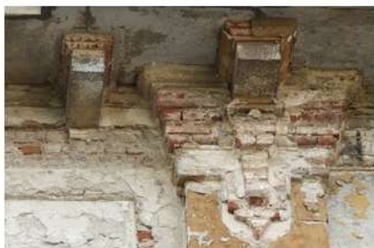
FOTO GRANDE_6c. Dettaglio della cornice di finestra del prospetto nord: dopo l'asportazione della tinta acrilica. La sagoma mistilinea della cornice risulta essere caratterizzata dalla compresenza di diversi materiali storicizzati: porzioni di malta di calce con finitura a finto mattone; stuccature con malta pozzolanica di colore giallo-nocciola; malte cementizie. Il restauro ha conservato tutte le stratificazioni, uniformando le superfici a vista con la stesura di una rasatura in malta di calce e successiva tinta ai silicati.
