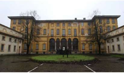
1d. Prospetto nord inizio '900. 1e. Prospetto sud della Villa nel 2016.
