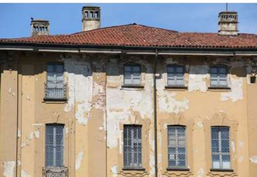
5a,b. Dettagli di degrado sul prospetto est della Villa. Le infiltrazioni dal tetto, per il cattivo smaltimento delle acque meteoriche, avevano asportato il rivestimento fino alla muratura.
